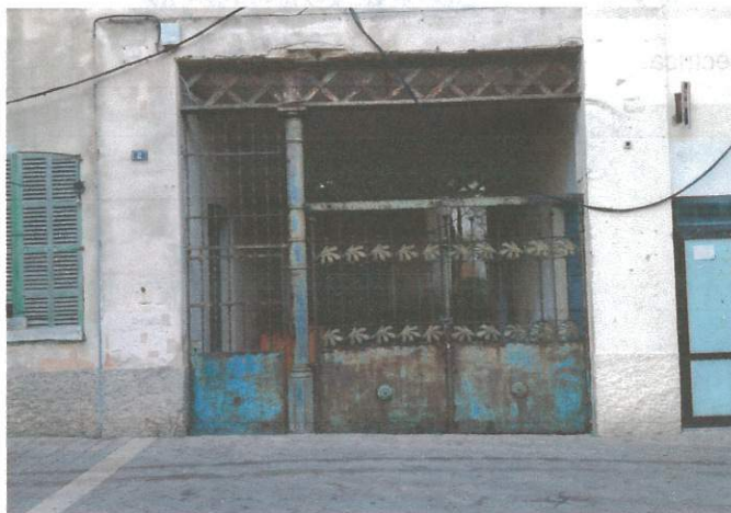
Pòrtic i reixa d'entrada Estructura metàl.lica
