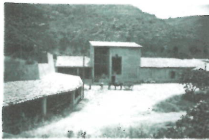
Vista general cimentera anys 1940
