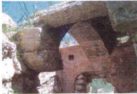
Vista d'un dels arcs que sostenen la volta
