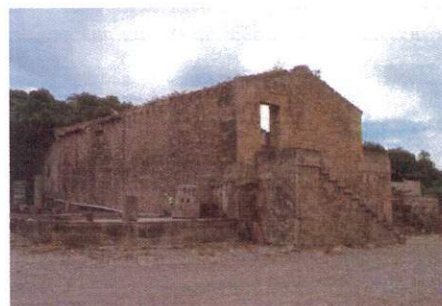
Edificació destinada als animals
