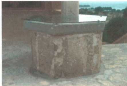
Coll de cisterna
