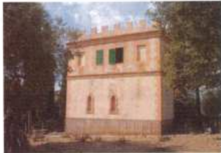
Lateral de la construcció
