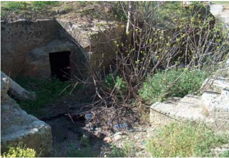
Restes de la cova 2 semidestruïda per la construcció d'una cantera
