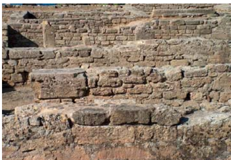
Vista dels murs de les domus
